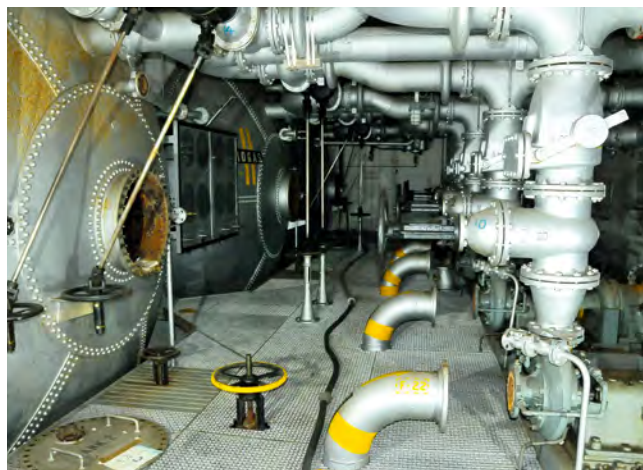
Manche der genieteten Tanks geben noch den Blick in ihr Inneres frei. Der massive Stahl wird wohl die nächsten 500 Jahre überdauern.
